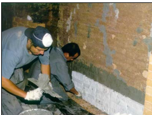
Módulos ZR de 38 mm de espesor pegados con cemento PYROFIX en horno de quemado de cerámicos
