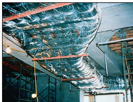
Manta Firemaster para protección pasiva contra incendio en instalaciones eléctricas
